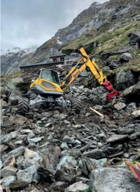
Schreitbagger im Einsatz
