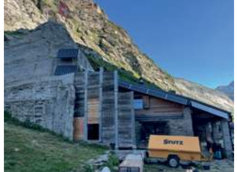
Aufgestockte Lawinenschutzwand inkl. neu erstelltem Betonabweiskeil
