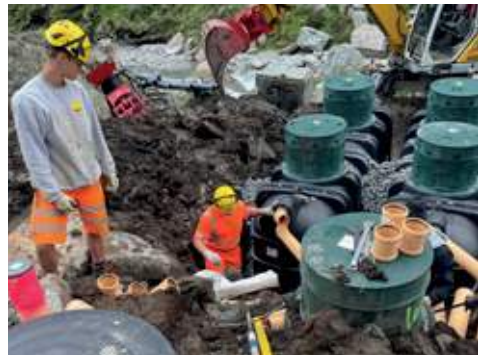
Versetzarbeiten der Komponenten für die Abwasserreinigungsanlage
