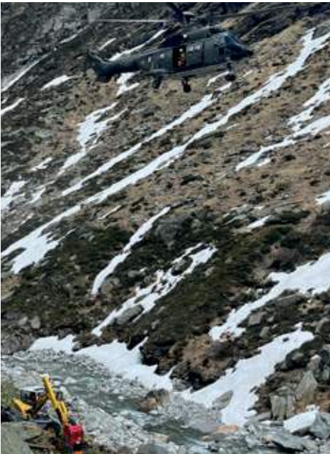
Baustellenbelieferung mit Super Puma
